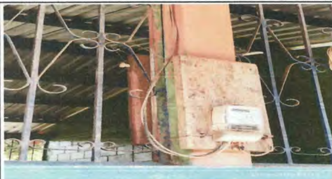
Foto 9: Reparación de cableo sistema eléctrico dentro de la escuela.
