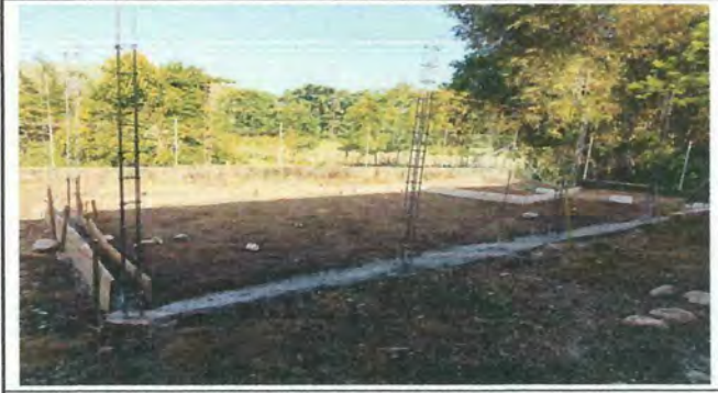
Foto 2: Mantenimiento de cocina, cambio de entechado a láminas troqueladas, reparación de pared de block, piso, ventanas, puertas y costaneras a metal.
