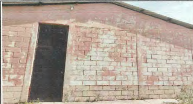
Foto 8: Cambio de pintura de puerta escolar interior y exterior.
