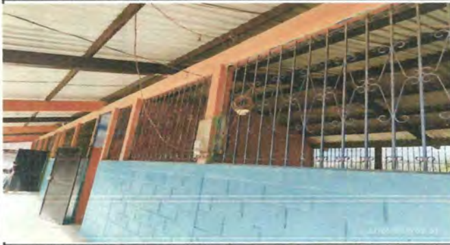
Foto1: Mantenimiento de ventanas, lijado y cambio de pintura.
