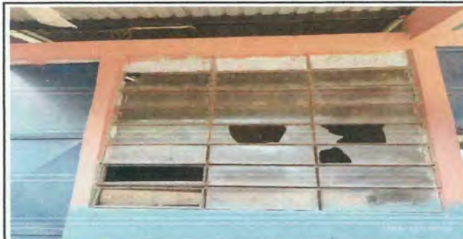
Foto 6: Sustitución de venta de vidrio, lijado y cambio de pintura de marco de metal.
