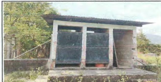
Foto 5: Sustitución de entechado sanitario escolar, costaneas, laminas, tazas sanitarias, reparación de puertas (lijado y cambio de pintura).
