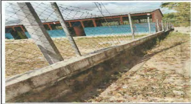
Foto 4: reparación de muro perimetral, tubos hg, malla galvanizadas y alambre de pua.
