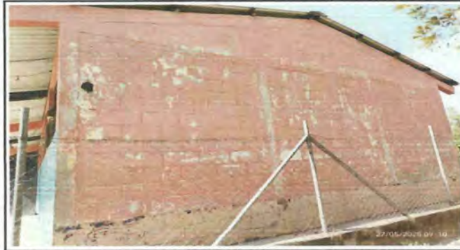
Foto 3: Cambio de pintura del edificio escolar, exterior e interior.
