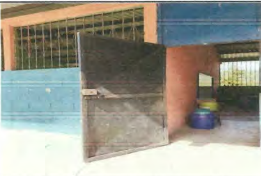
Foto 7: Cambio de chapas de las puertas del edificio escolar.
